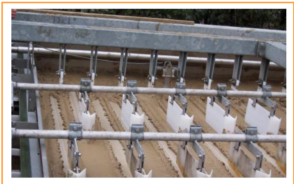
Obr.1 Odvodněné kaly z úpravny prací vody na pásovém zahušťovači
